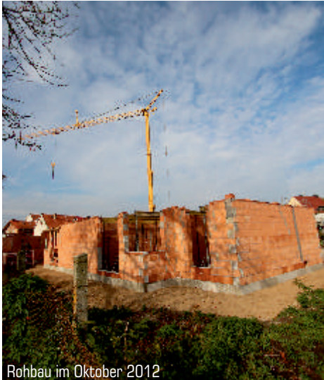
Rohbau im Oktober 2012
